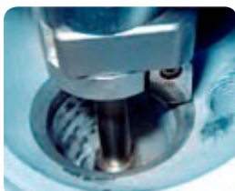
Bild 1: Der Ventilsitzring wird ausgefräst.
